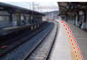
ホーム点字ブロック内方線
