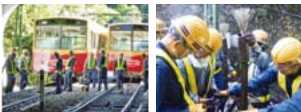
鋼索線の点検・整備
